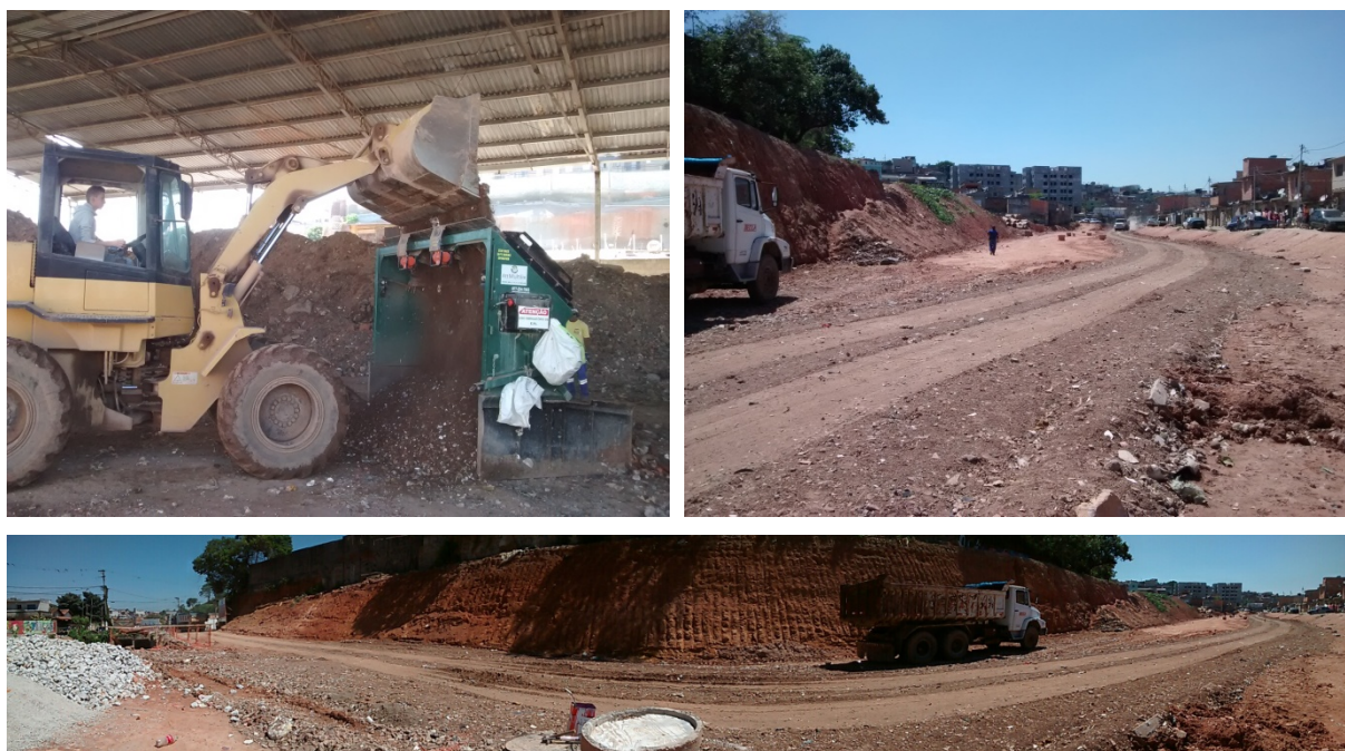
Figura 4 – Recuperação de rejeitos em ATT e reuso do produto pela Secretaria de Obras do Município de Carapicuíba
