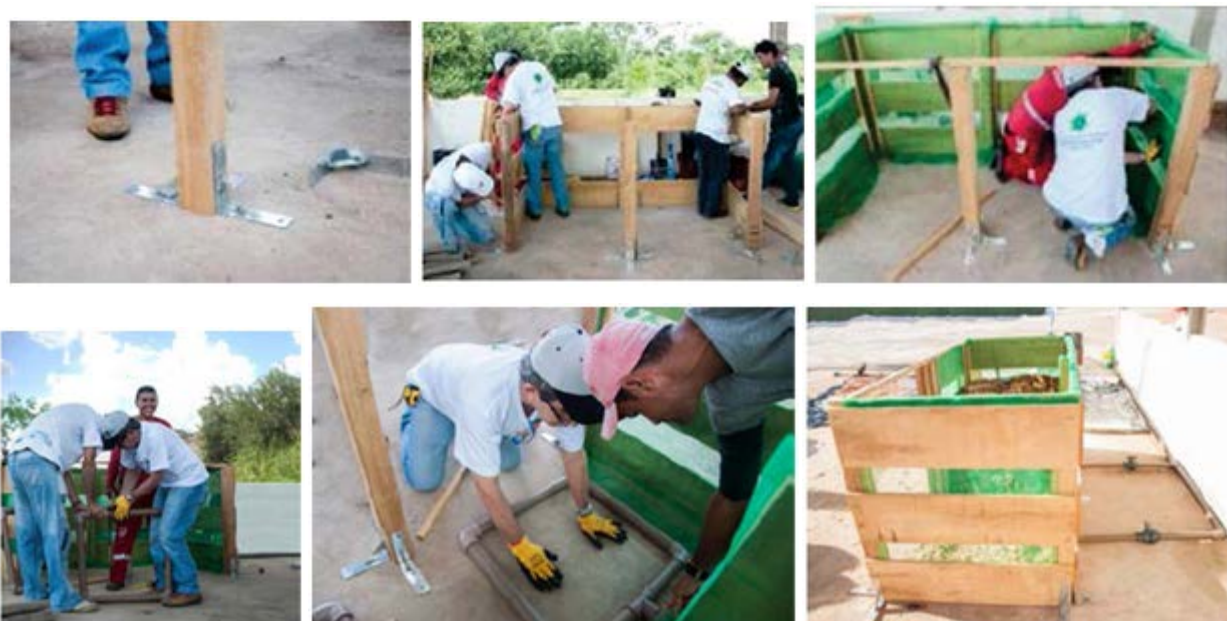
Figura 7 – Alguns dos passos para a preparação das baias de compostagem.
